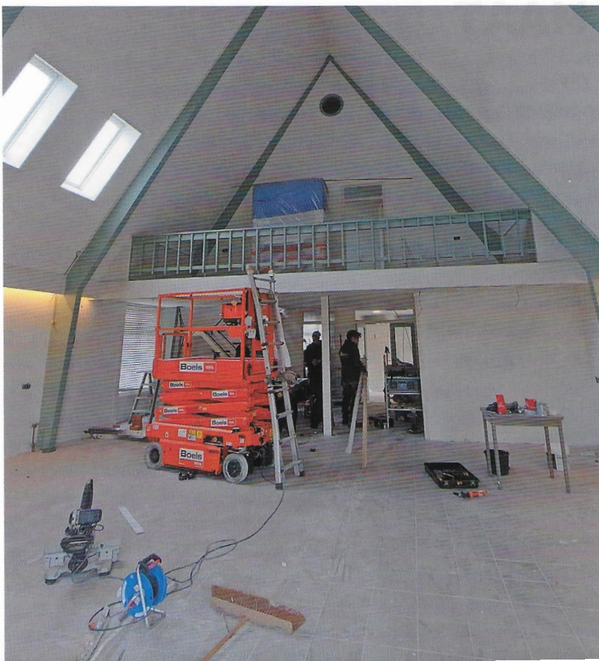
Werkzaamheden in de Vermaning
